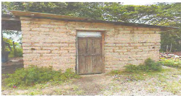
Foto 3: Puerta de la cocina
