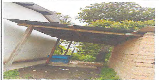
Foto 4: Paredes de la cocina
