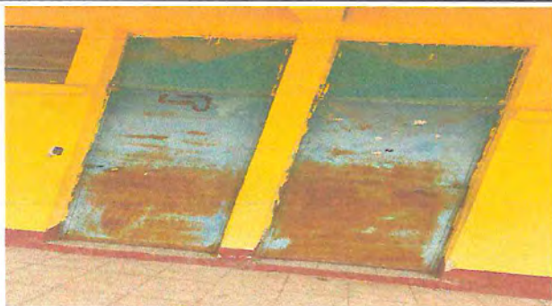
Foto 1: Sustrucción de puertas de las aulas
