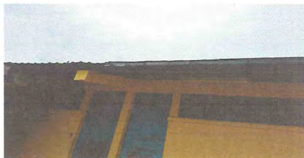
Foto 2: Sustrucción de puertas de las aulas
