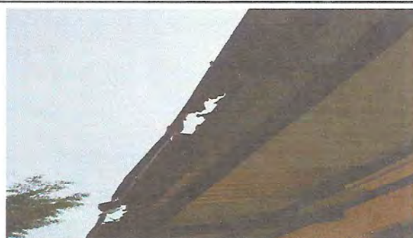
Foto 4: Sustrucción del techo
