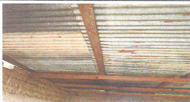
Foto 3: Sustrucción de techo de la cocina
